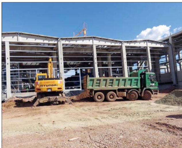
Заводът за преработка на отпадъци ще заработи наесен.
