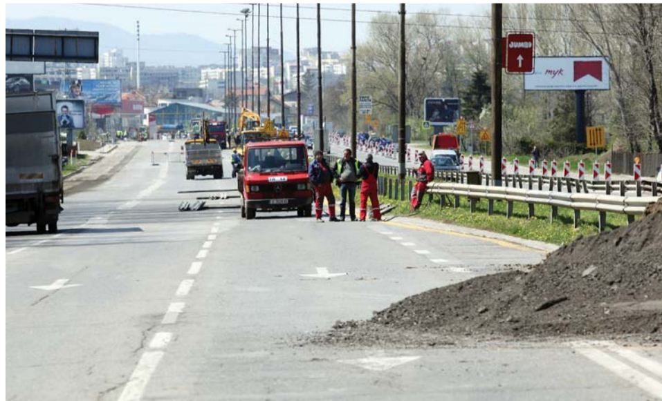
До началото на септември ще продължат работите по бул. „Цариградско шосе“.
